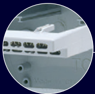
Terminal de neutro y/o tierra Earth/neutral bar
